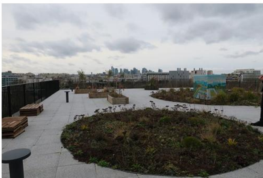
Black compte 9 000 m 2 d'espaces extérieurs, tels ces balcons d'étages au R+6. © Jgp
