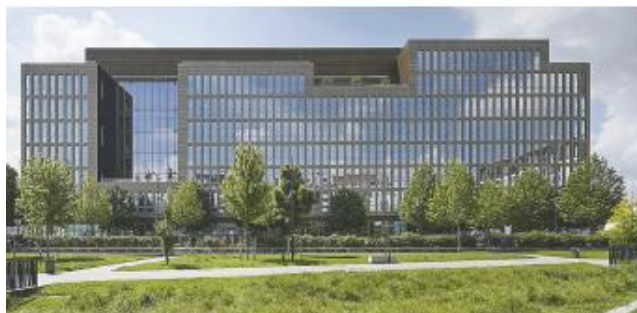
D'ici la fin du premier trimestre 2026, les 2700 agents concernés intégreront le bâtiment de 29 000 m 2 .
